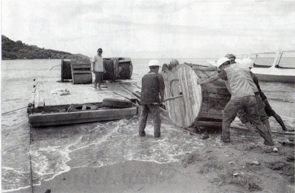
PEMASANGAN: Petugas PLN saat melakukan pemasangan jaringan kabel bawah laut menuju Gili Gede, beberapa waktu lalu.
